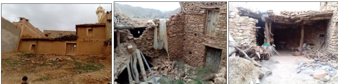
Fig. 10 – Habitations en pierre abandonnées avec différents degrés de détérioration dans l'agglomération de Ouarka (les auteurs, 2018).
